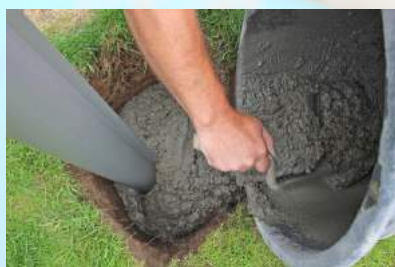
Verfüllung mit Beton
