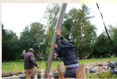
Aufstellung von Stützmasten
